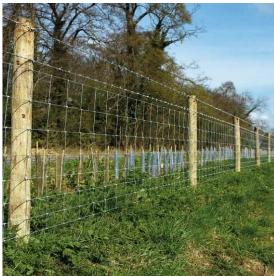
Photo 23 : Exemple de grillage de type Ursus (grillage à mouton) (directclotures.com)
